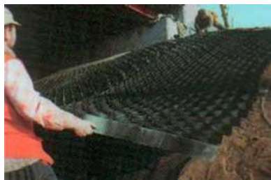
Рис. 1. Конструкция геокаркаса
