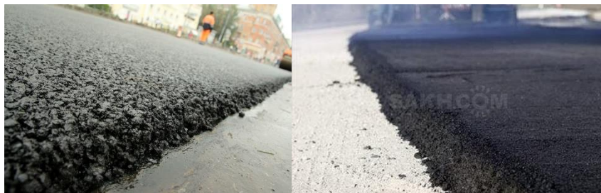
Рис. 1. Сравнение структуры щебёночно-мастичной смеси и асфальтобетонной смеси
