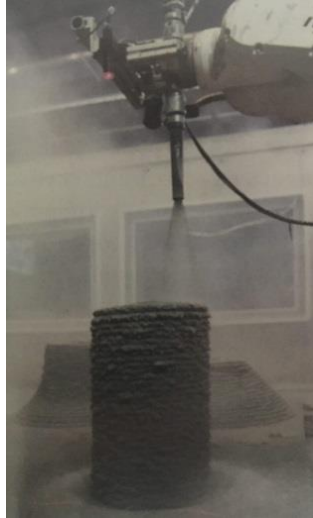
Рис. 4. Метод напыления бетонной смеси
