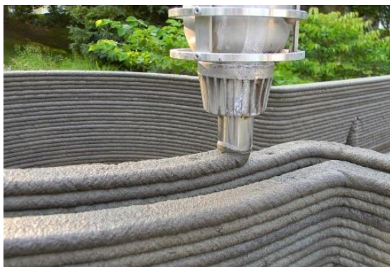
Рис. 3. Послойный метод формирования конструкции
