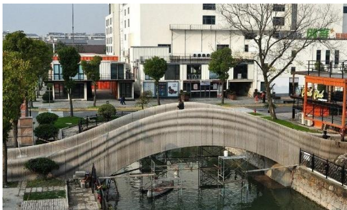
Рис. 1. Мост в Шанхае, изготовленный с использованием 3d-печати. Китай
