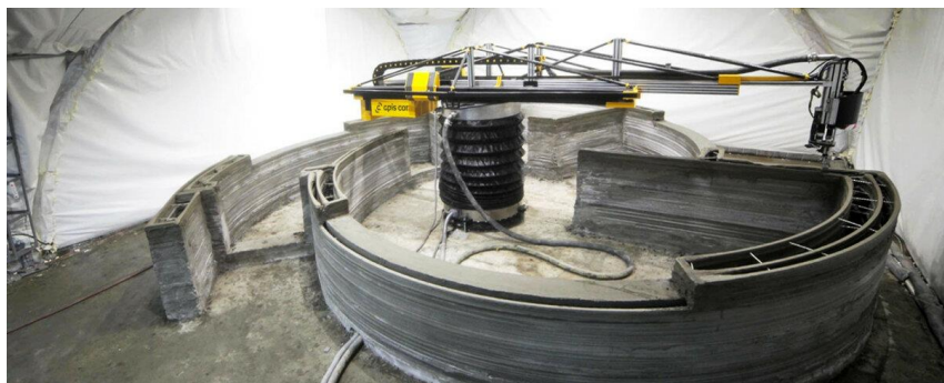
Рис. 1. Строительный 3D принтер
