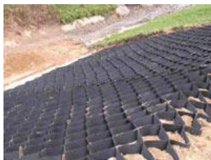
Рис. 3. Применение георешеток
