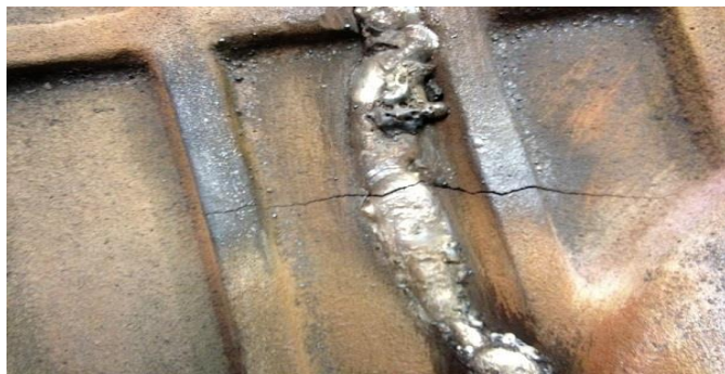
Рис. 2. Силовая трещина ввиду некачественного усиления шва
